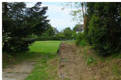
Muret en pierres, sur site
