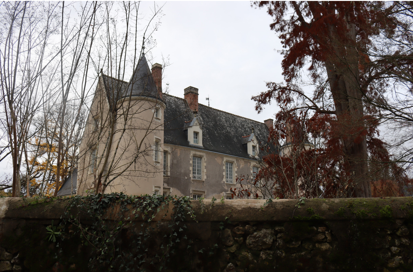
Photographie 4. Vue sur la façade Est depuis le Chemin des Archevêques (Auddice Val de Loire)
