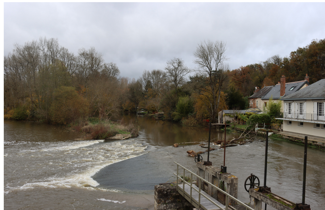
Photographie 8. L'Indre bordée par une lisière arborée (Auddicé Val de Loire)
